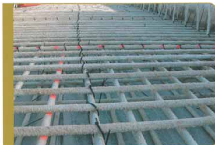
Estructura de barras de RTHp
